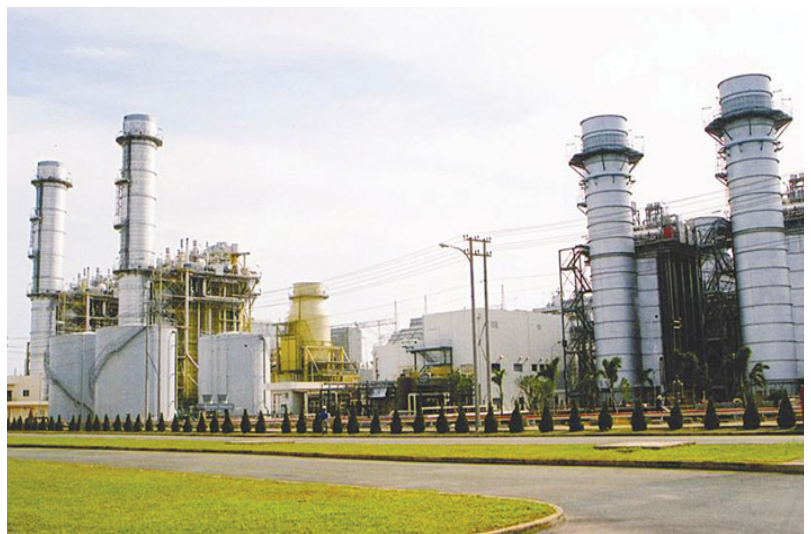
Nhà máy nhiệt điện Phú Mỹ
